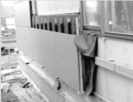
**B<sub>2</sub>) Tragrost aus Systemprofilen aus Alu oder aus verzinktem Blech**
