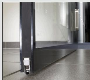
In die Glaskonstruktion integrierte absenkbare Bodendichtung.
